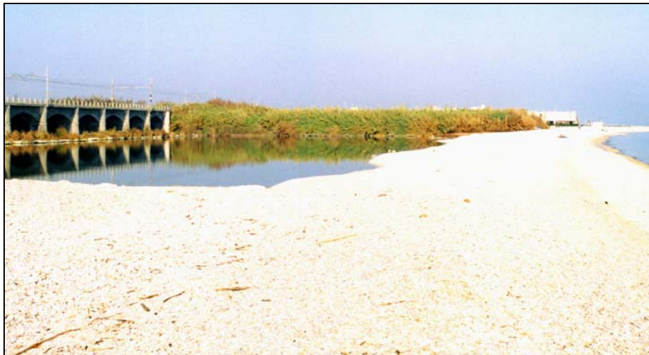
Figura 6-2 Foce del fiume Metauro (foto effettuata nei pressi del ponte ferroviario tra la località Metaurilia e l' abitato di Fano)
