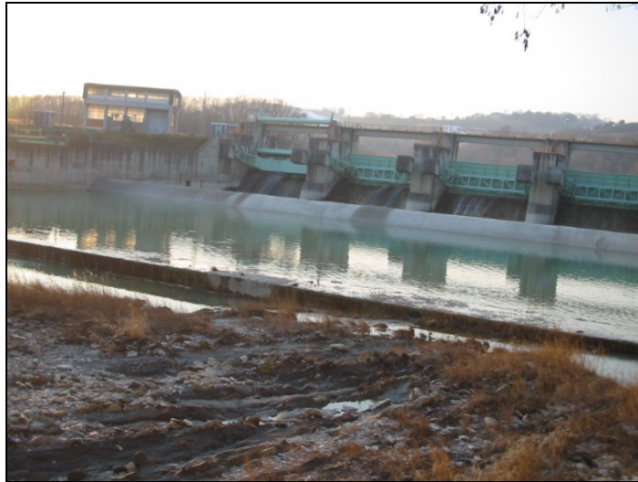
Figura 6-6 Diga di proprietà dell' Enel, in prossimità della località Tavernelle
