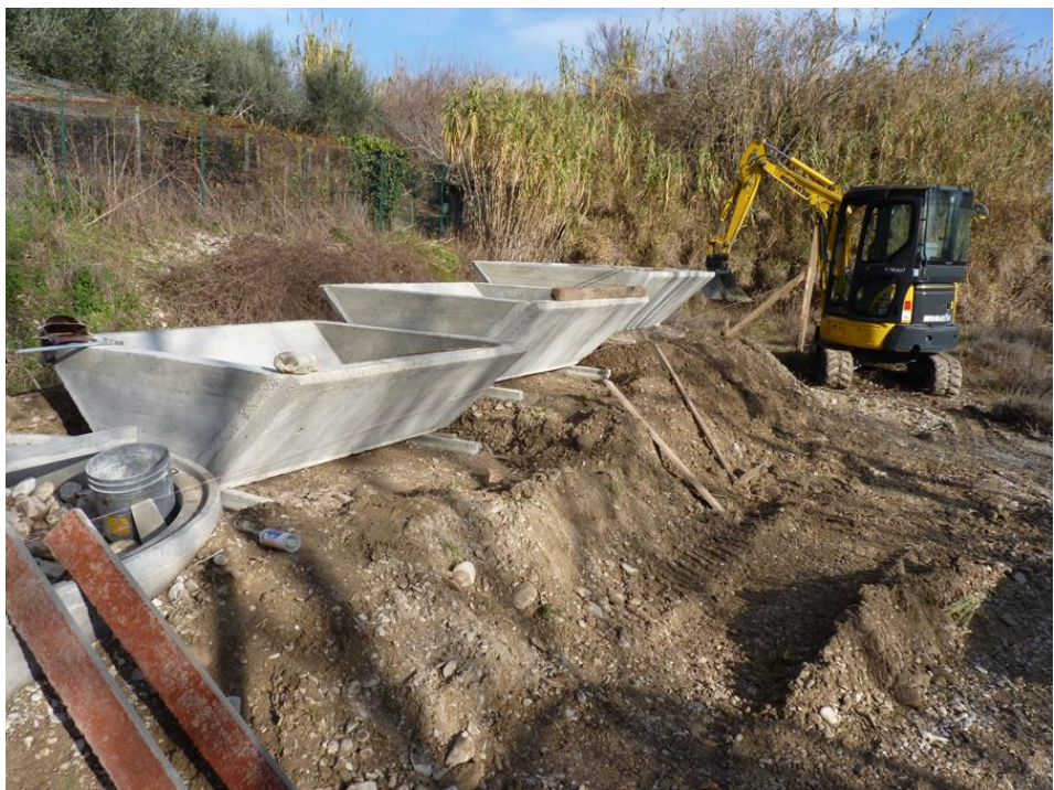
5 gennaio 2012, si sta posizionando la serie di vasche collegate fra loro che rappresentano il corso schematizzato di un fiume dalla sorgente alla foce
