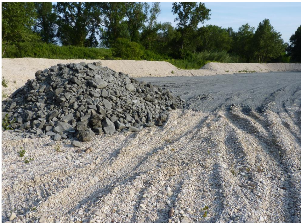
2 giugno 2010, si sta posizionando lo strato di argilla per impermeabilizzare il fondo
