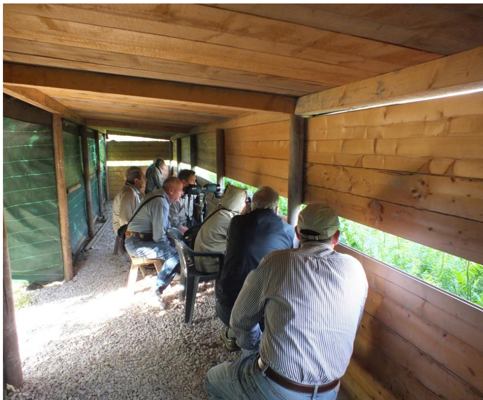
12 maggio 2013, soci dell'Argonauta nell'osservatorio sul lato est quasi terminato
