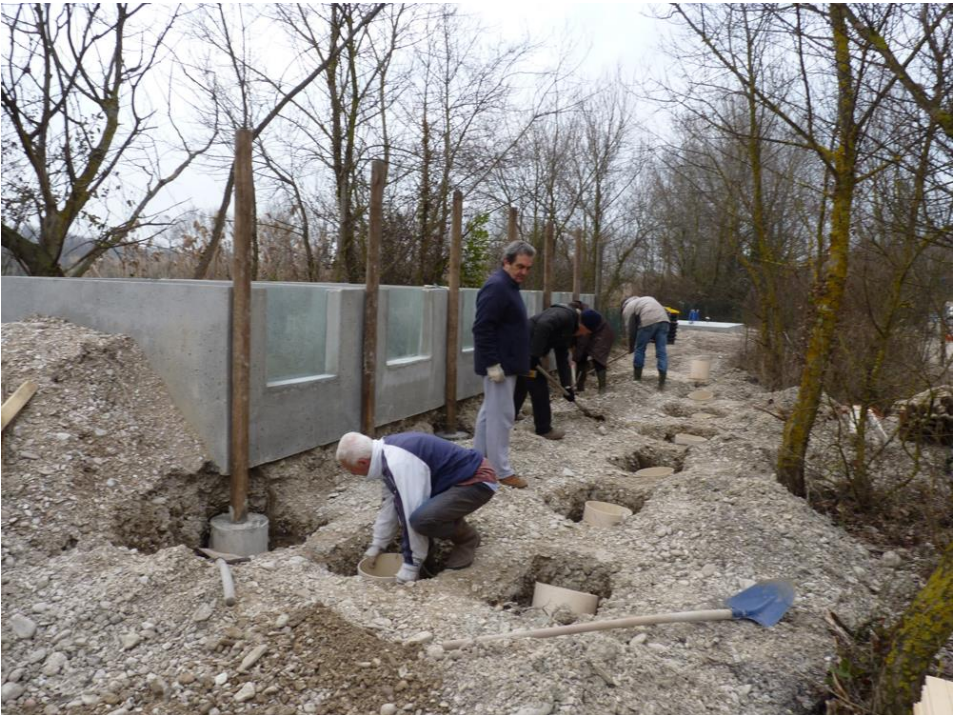
7 marzo 2011, i volontari dell'Argonauta iniziano i lavori della struttura coperta in legno che ospiterà gli acquari. In primo piano Maurizio Righi e Ferruccio Serafini
