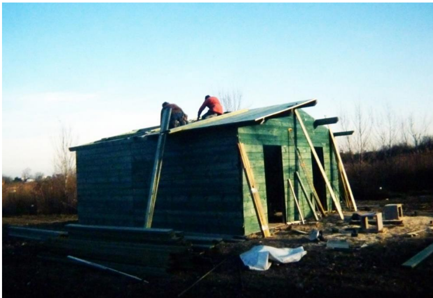
25 gennaio 1996, costruzione del centro visite con struttura in legno
