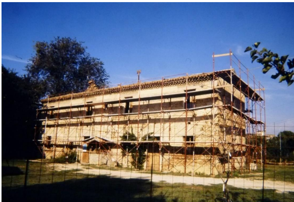
17 ottobre 1994, iniziano i lavori di recupero conservativo dell'edificio
