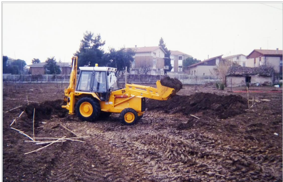
15 dicembre 1989, si inizia lo scavo per realizzare il laghetto
