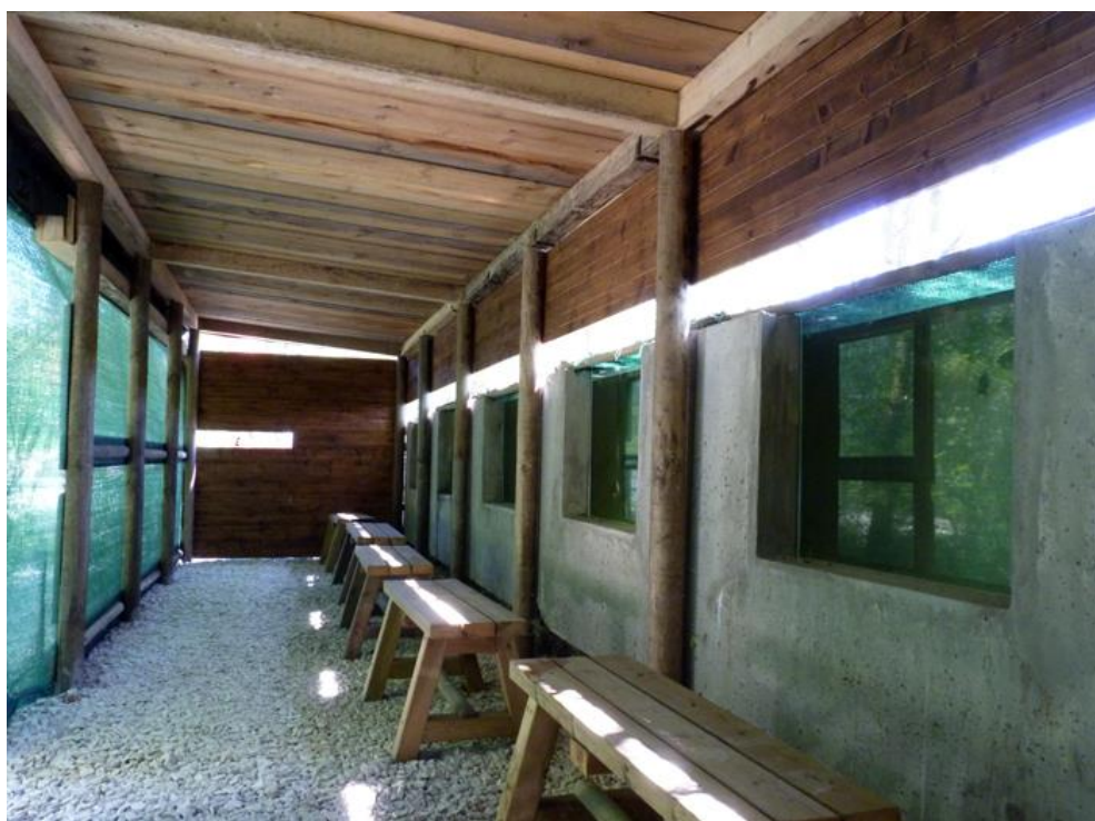
16 giugno 2011, gli acquari e la struttura in legno che li ospita appena terminati
