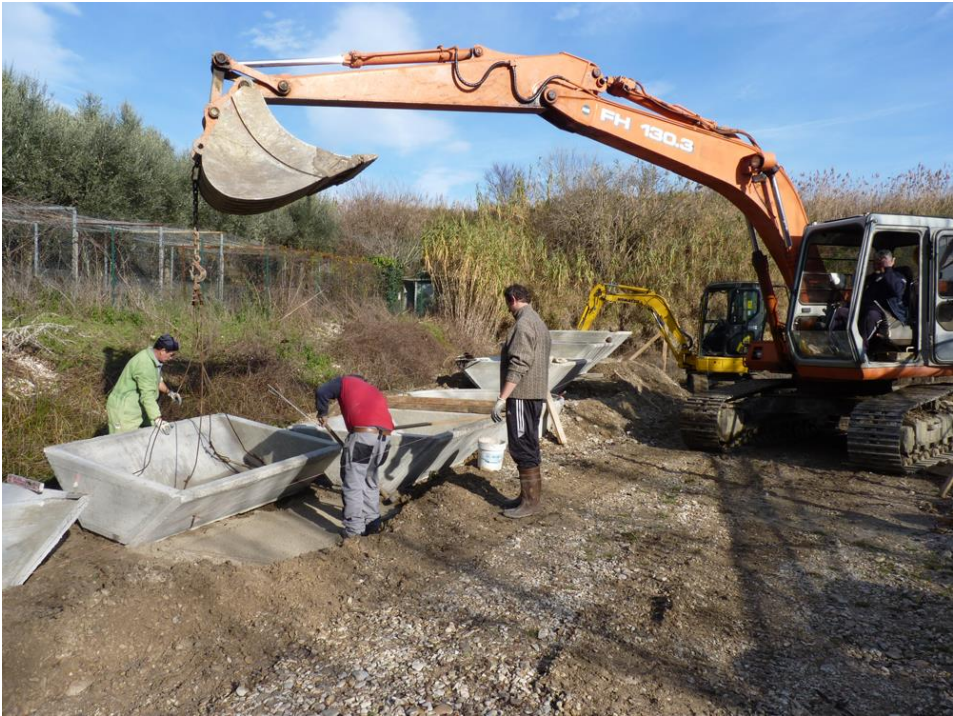
5 gennaio 2012, una volta sistemate, le vasche saranno alimentate con l'acqua prelevata dal lago mediante una pompa, passando secondo la pendenza dall'una all'altra
