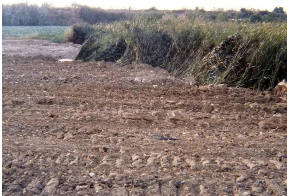
10 ottobre 1980, sul lato sud la ruspa sta spianando i cumuli e li spinge entro lo stagno, la vegetazione acquatica è man mano sepolta dal terreno di riporto
