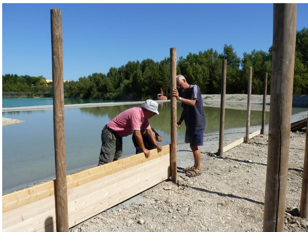
9 agosto 2010, i volontari dell'Argonauta, tra cui Virgilio Dionisi ed Enrico Tosi, iniziano a costruire l'osservatorio sul lato di sud-est dell'acquitrino
