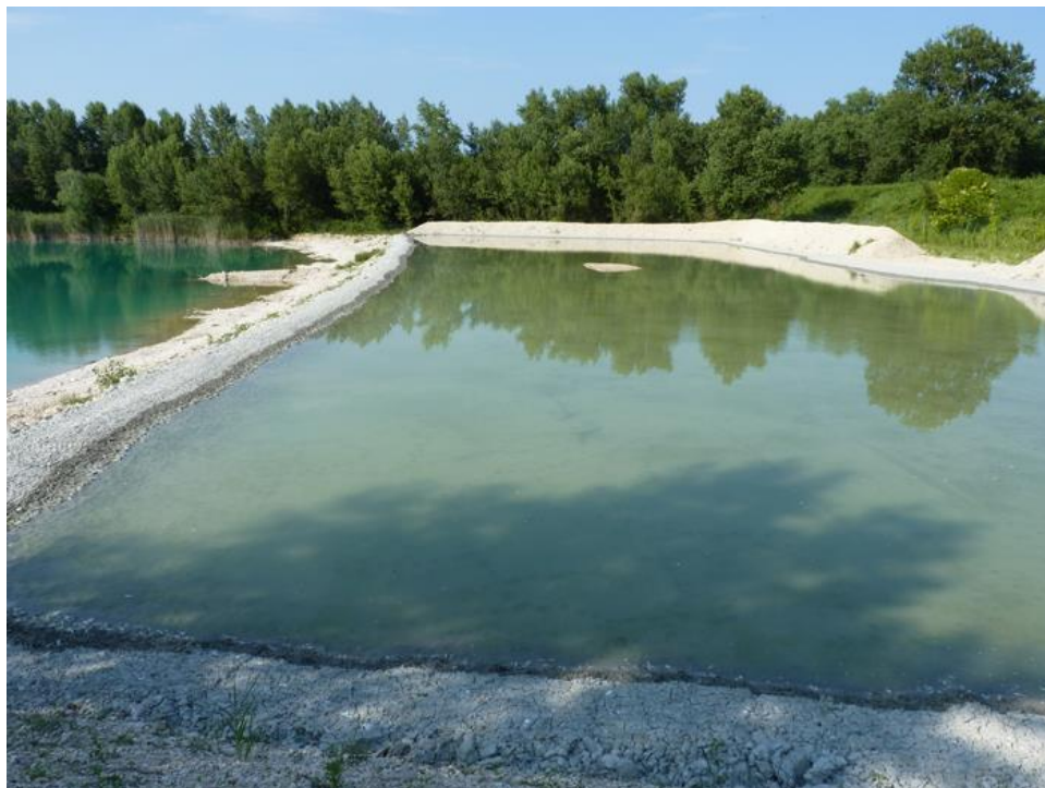
5 luglio 2010, l'acquitrino è terminato ed una condotta vi porta l'acqua prelevata dal lago mediante una pompa
