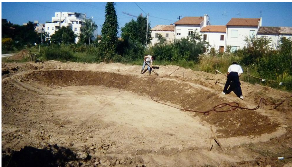
15 giugno 1994, si lavora per sagomare il laghetto scavato nel dicembre 1989 per sistemarvi sopra lo strato di derbigum come impermeabilizzazione
