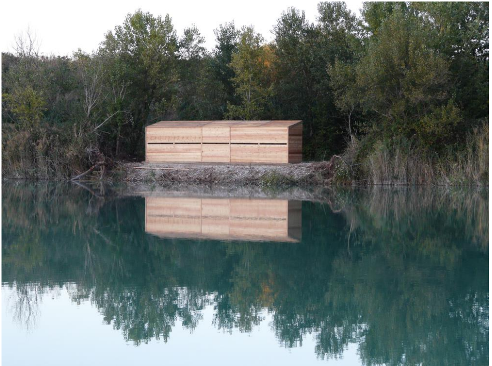
5 ottobre 2008, l'osservatorio appena terminato
