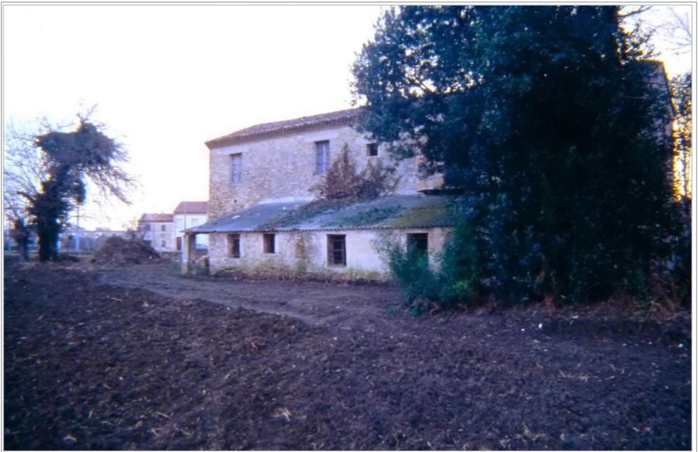
15 dicembre 1989, così appare il retro della casa, con il settore più basso adibito a cantina in quanto più fresco essendo rivolto a nord-ovest. Il tetto è in eternit come si usava in quegli anni
