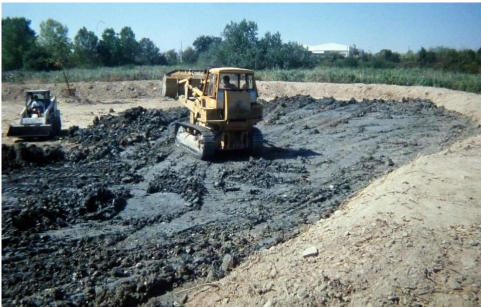
15 agosto 2001, preparazione di un nuovo acquitrino (nella mappa del 2022 a pag. 168 è la zona 6b ). Dopo aver asportato il fragmiteto, approfondito il terreno e creato un basso argine attorno, si passa alla sistemazione di uno strato di argilla prelevata in loco per assicurare la tenuta del fondo in modo da trattenere l'acqua. Si tratta dell'argilla pliocenica di origine marina sottostante allo strato di ghiaia nell'area della cava
