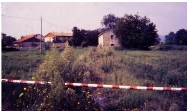
Estate 1989, così ci è apparsa Casa Archilei nella nostra prima visita, dalla sbarra di accesso su via Ugo Bassi. Il campo attorno, prima coltivato a grano, è in abbandono
