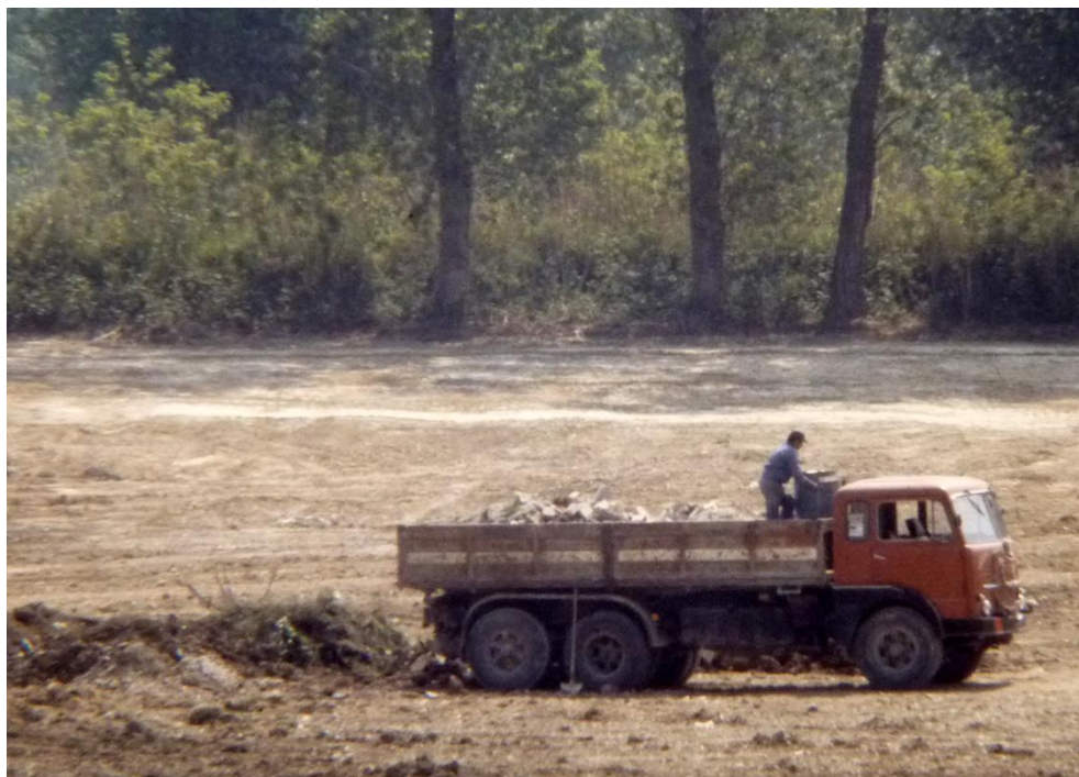
10 maggio 1979, sul lato est prosegue il riempimento con terra e macerie
