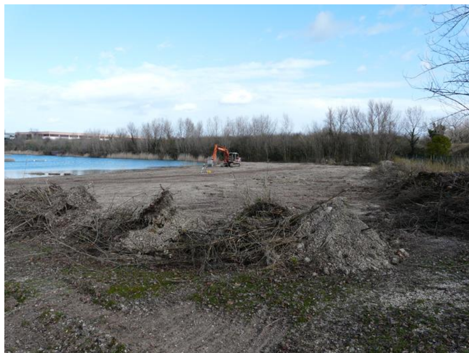
28 febbraio 2010, iniziano i lavori di creazione dell'acquitrino, con la decorticazione dell'arbusteto e il livellamento del terreno
