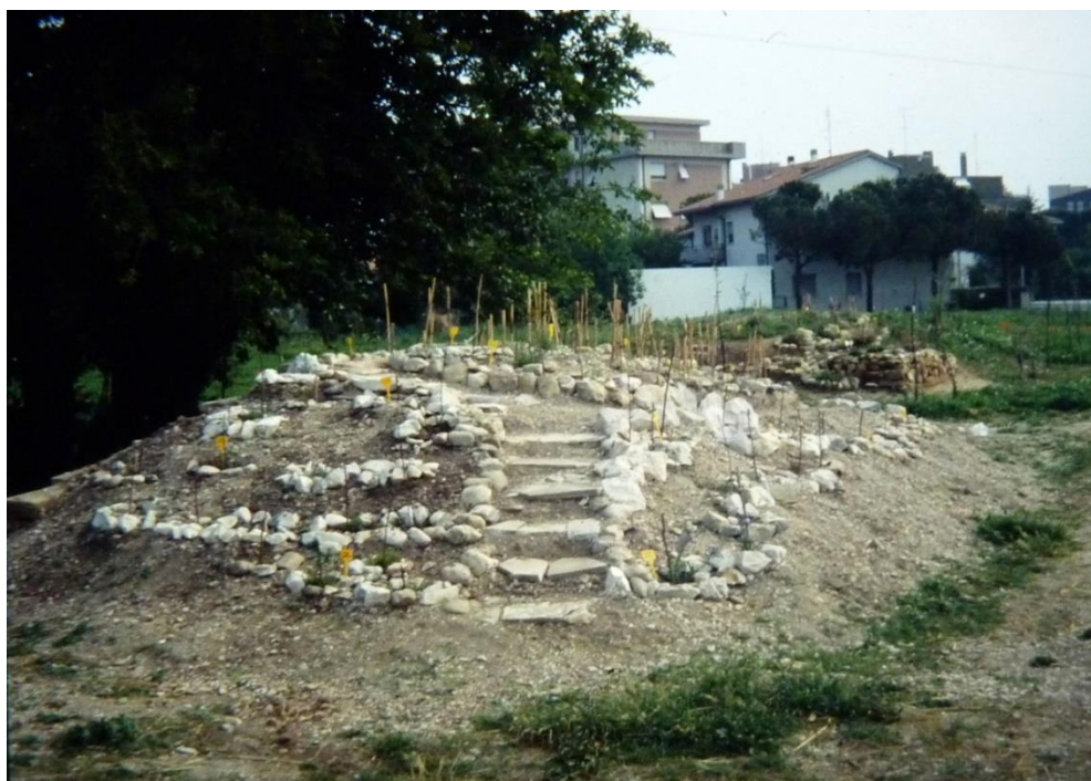
25 maggio 1990, il giardino roccioso in fase di preparazione e in secondo piano la collinetta con muretto a secco di blocchi di arenaria
