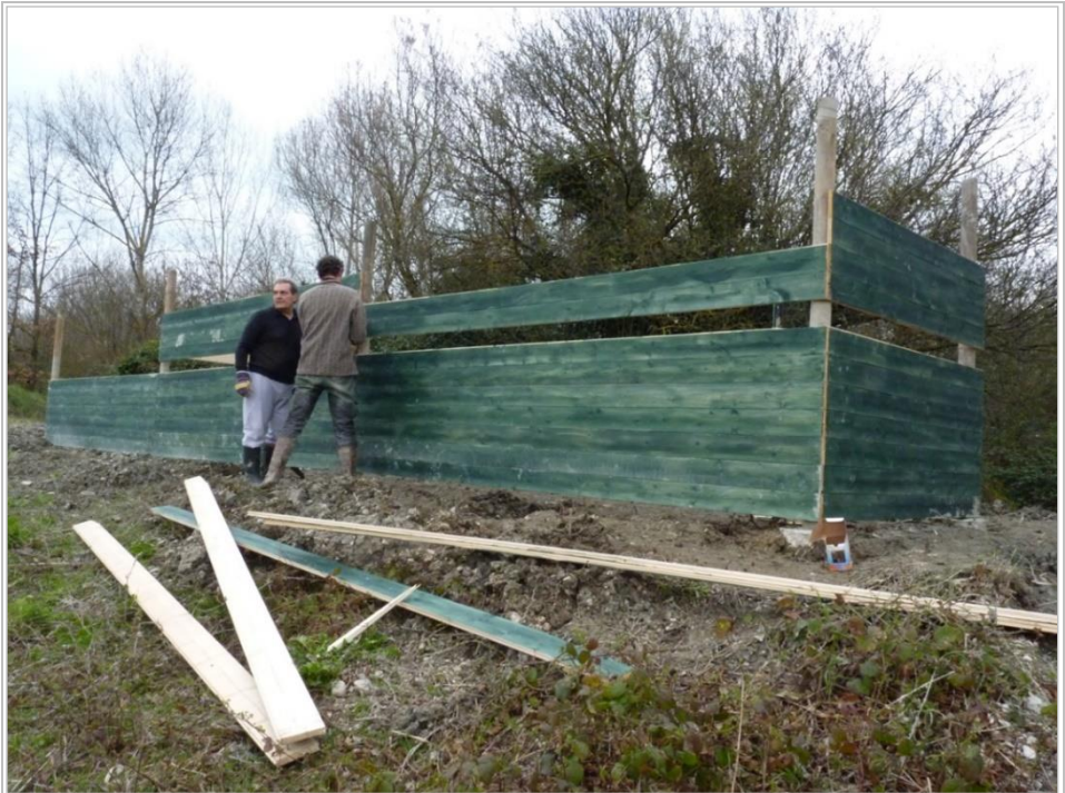
19 marzo 2011, rifacimento dell'osservatorio sul lato est dello Stagno
