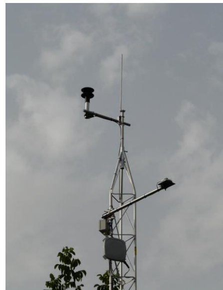
Stazione meteo (foto L. Poggiani)
