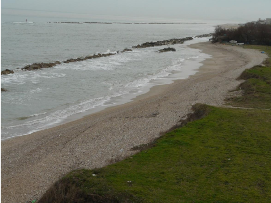
Doppia fila di scogliere di massi calcarei sistemate a difesa della spiaggia di Fano (PU), 2004
