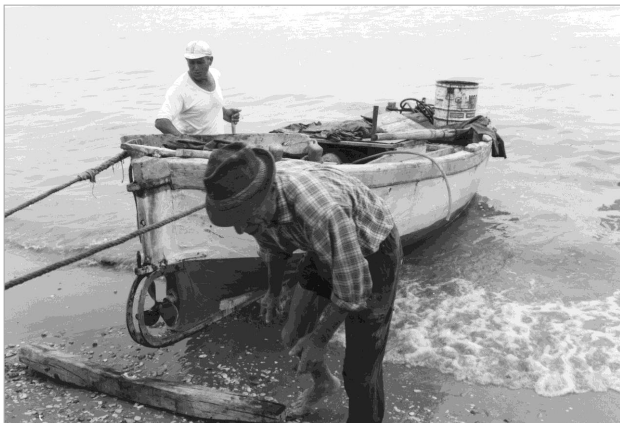
Maggio 1968, spiaggia presso la foce di Fosso Sejore. I legni (palanche) cosparsi di sego, posati a terra, servono a far scivolare meglio la chiglia della barca
