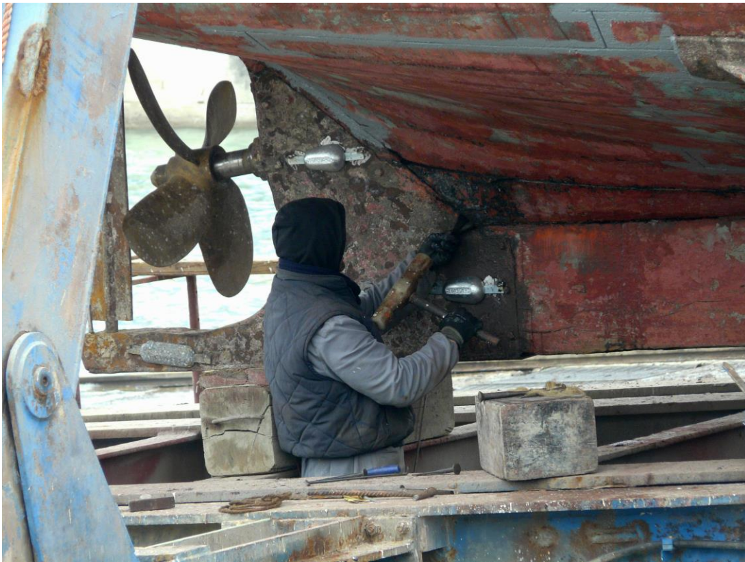
Febbraio 2010, Porto di Fano. Operaio al lavoro nello squero, che opera con un particolare tipo di martello sulla chiglia della barca
